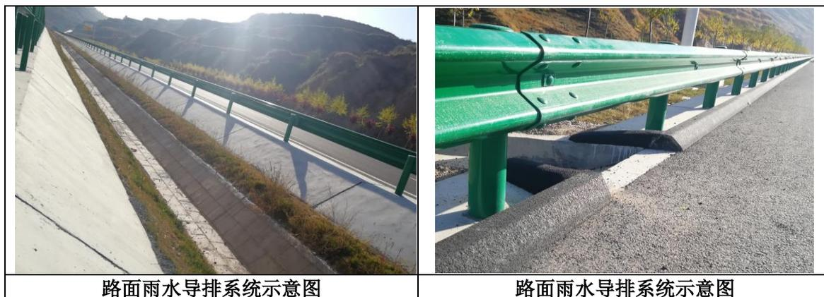
路面雨水导排系统示意图
